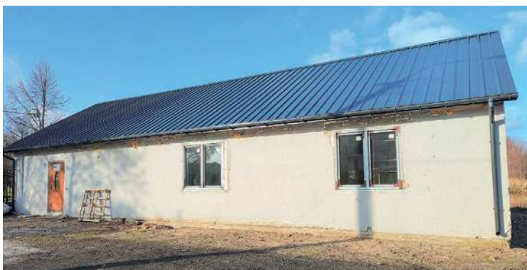
Remont świetlicy wiejskiej w Niechodzinie
