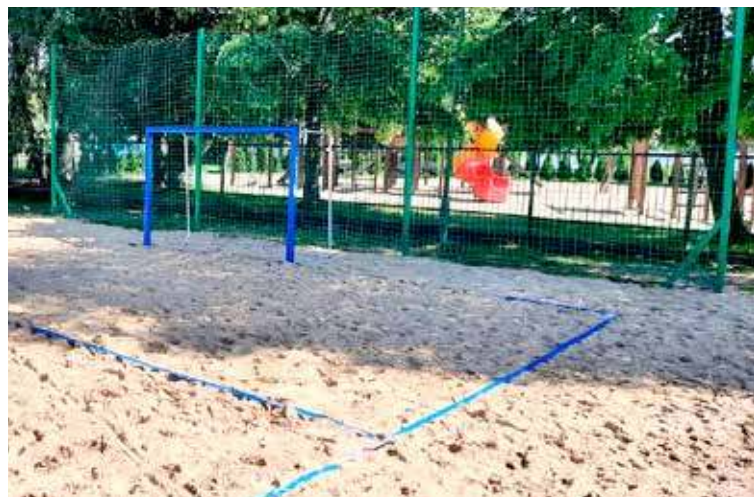
Ostatnim elementem prowadzonej niewielkiej inwestycji na plaży był montaż piłkochwyty
