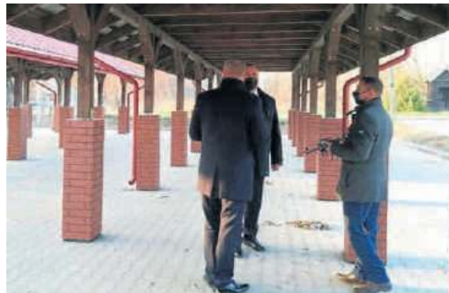
Wicemarszałek Rafał Rajkowski odwiedził plac budowy zielonego targowiska w Siemnie.
