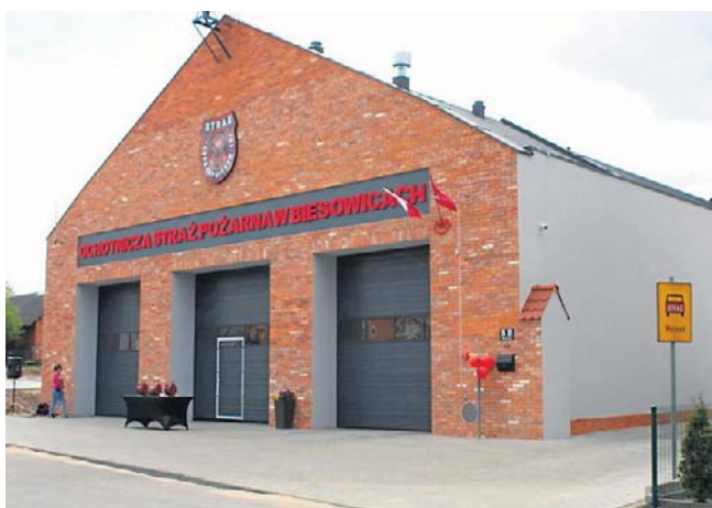
Remiza Ochotniczej Straży Pożarnej w Biesowicach
