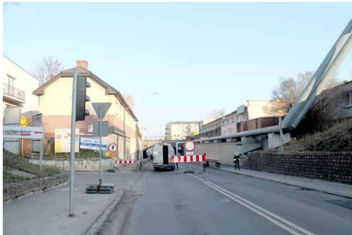
Ciąg dalszy inwestycji PKP rozpoczął się wczoraj, tj. w poniedziałek zamknęli wiadukt na Pierwszej Brygady
