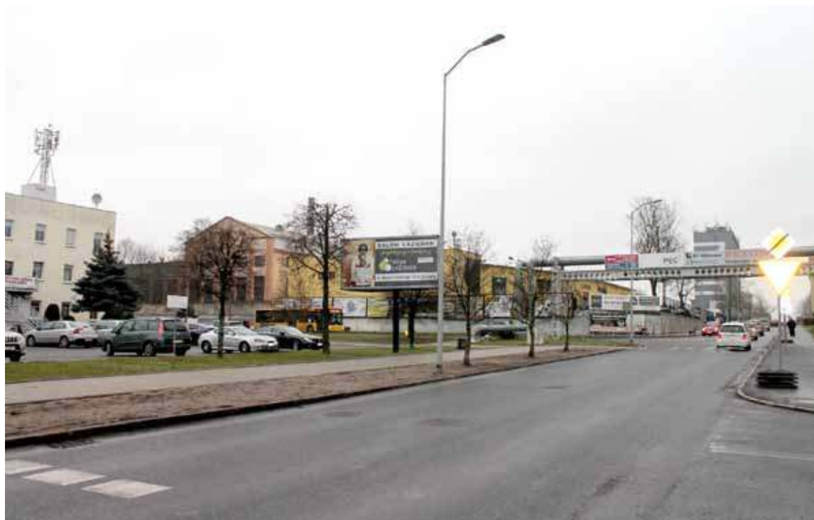
Ul. Pierwszej Brygady po remoncie
