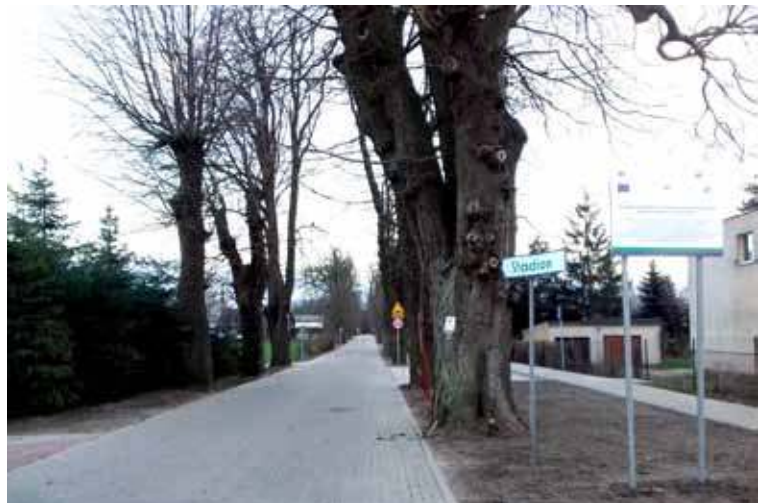
Po przeprowadzonym remoncie droga posiada nawierzchnię wykonaną z kostki brukowej i betonowej
