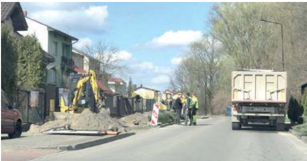
Będzie chodnik przy Bagiennej
