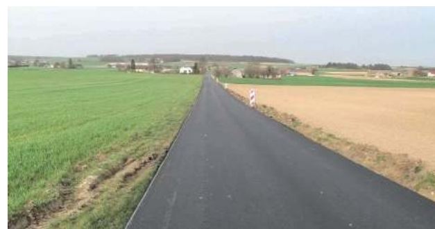
Ponad pół miliona złotych kosztowała przebudowa drogi gminnej w Elizówce
