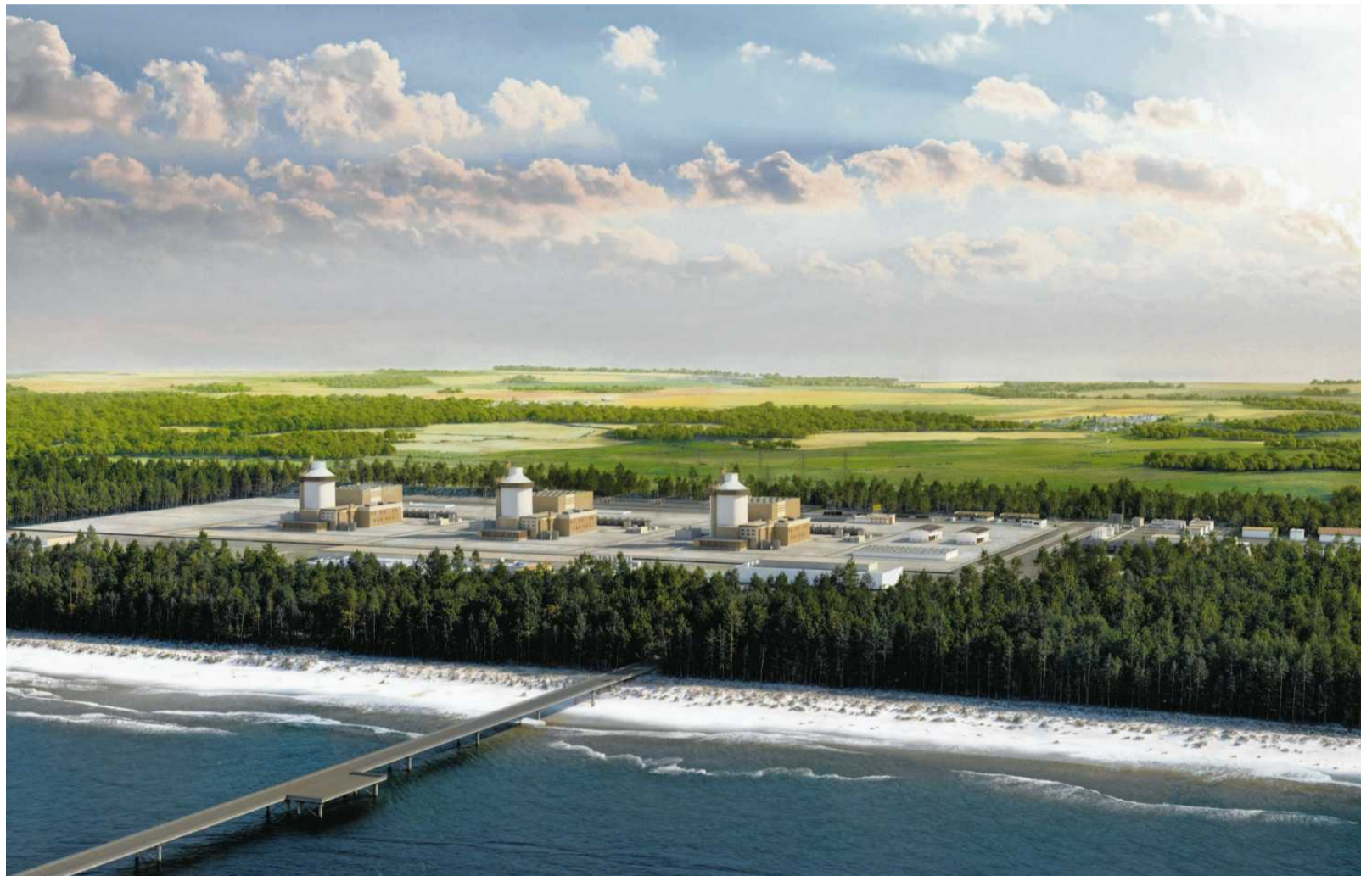
• Elektrownia jądrowa Lubiatowo-Kopalino będzie fundamentem transformacji energetycznej Polski i podstawą przyszłego systemu elektroenergetycznego FOT. POLSKIE ELEKTROWNIE JĄDROWE
