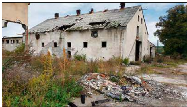
Kto dokona rozbiórki obiektu z dachem z eternitu?
