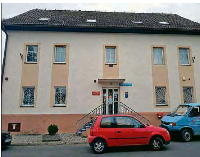
Tak budynek prezentuje się po remoncie.
