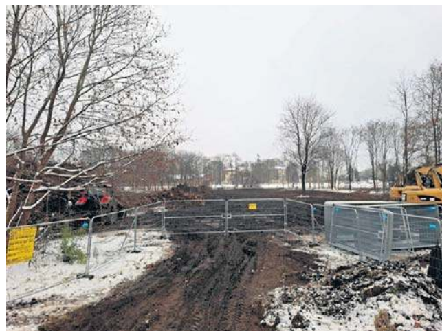
Wykonawca ruszył z pierwszymi pracami. Trwa porządkowanie terenu pod budowę Mediateki
