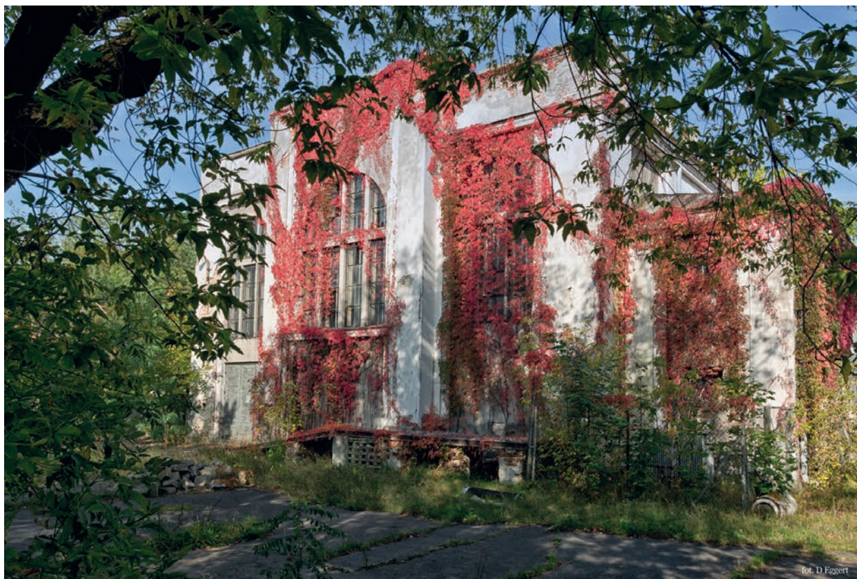
Budynek dawnej elektrowni w Falenicy, obecnie magazyn firmy Stoen, fot. D. Eggert, źródło: Fotopolska
