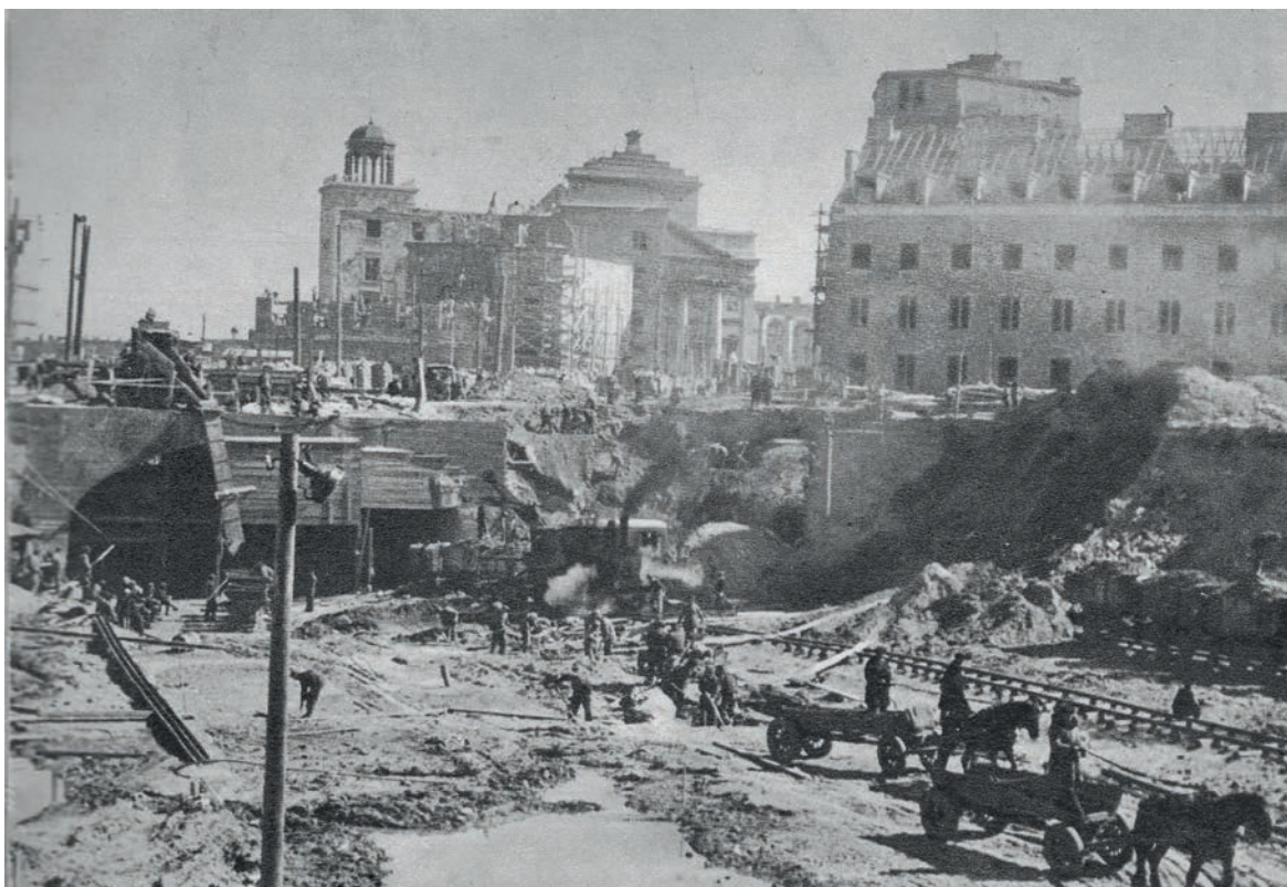
Budowa tunelu, widok od strony zachodniej, 1948
