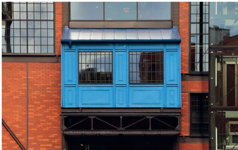
Sterownia na fasadzie Elektrowni Powiśle po rewitalizacji, źródło: Fotopolska
