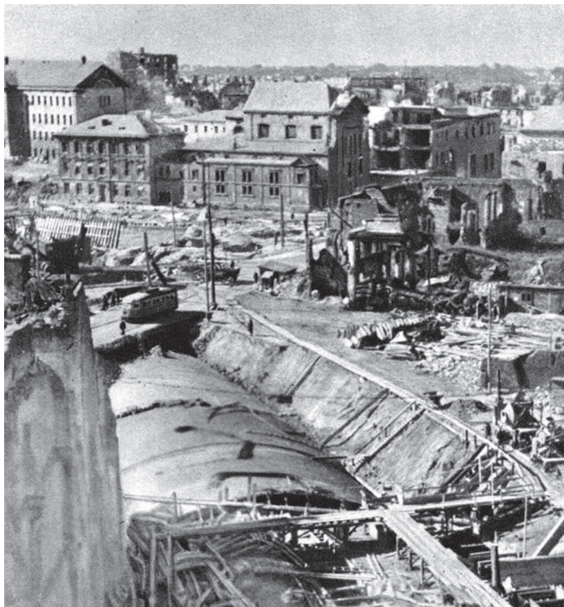
Betonowanie stropu tunelu, 1948 r., źródło: domena publiczna
