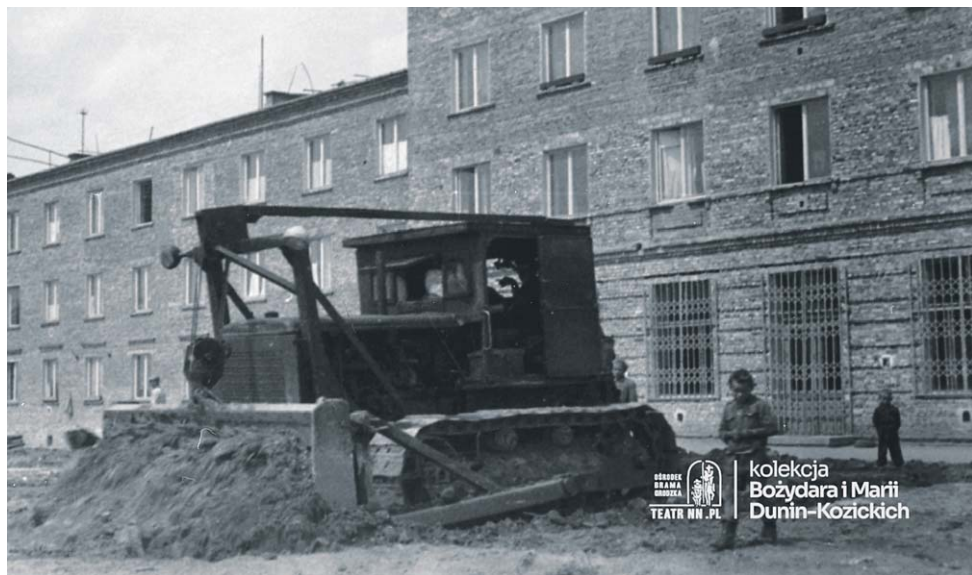
Budowa ZOR Bronowice I
