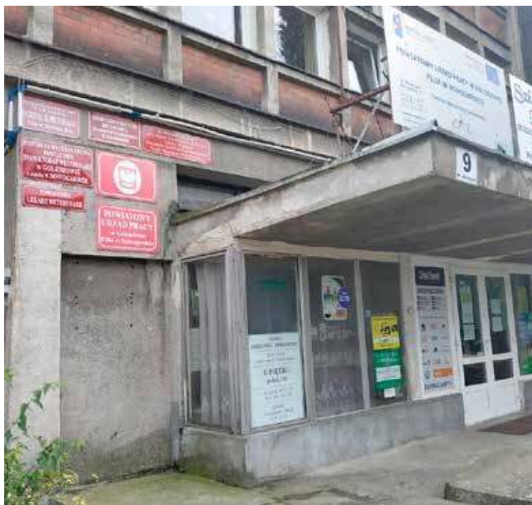
W budynku po dawnym hotelu działalność prowadzi obecnie szereg instytucji
