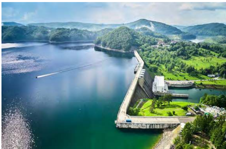
Zapora wodna i Jezioro Solińskie. Foto – Adobe Stock
