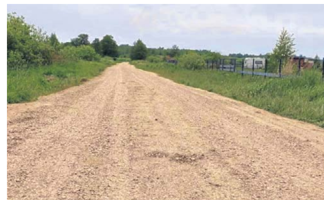
Nowa droga została wyrównana i zostanie oznakowana
