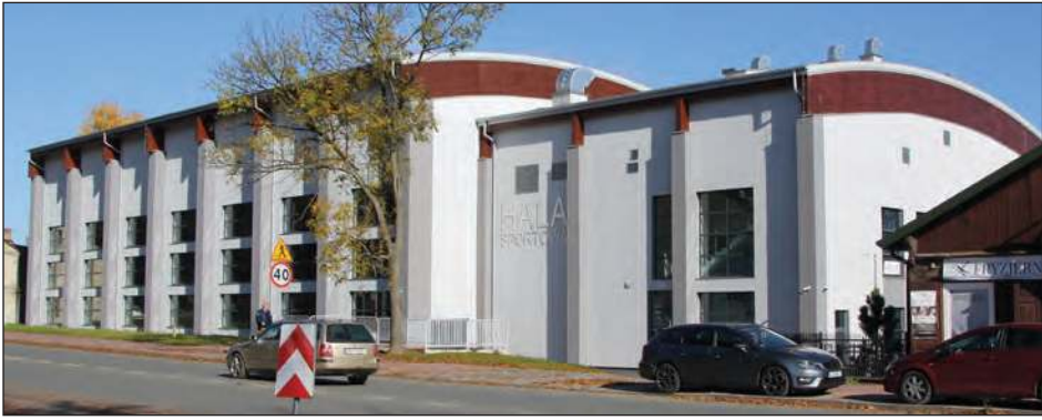
Od teraz mieszkańcy będą mogli korzystać z największego i najnowocześniejszego obiektu tego typu w powiecie
