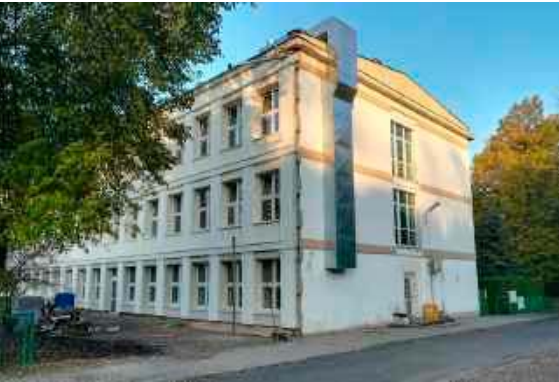
Przerwany remont niebawem zostanie wznowiony
