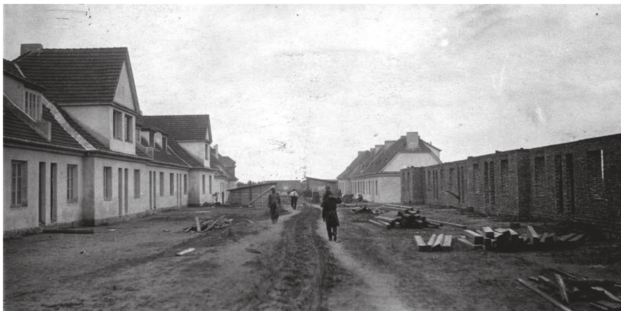
Budowa osiedla mieszkaniowego „Zdobycz Robotnicza”, Ul. Chełmżyńska (ob. Płaniczka) 1927, źródło: Narodowe Archiwum Cyfrowe
