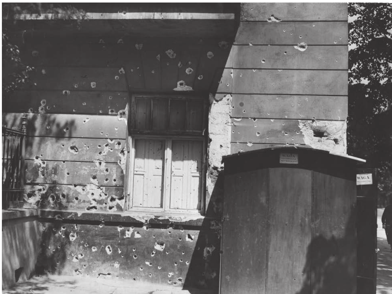
Uszkodzona ściana kamienicy przy Alejach Ujazdowskich 9. Widoczne ślady po ostrzale z karabinu maszynowego. Maj 1926, źródło: Narodowe Archiwum Cyfrowe
