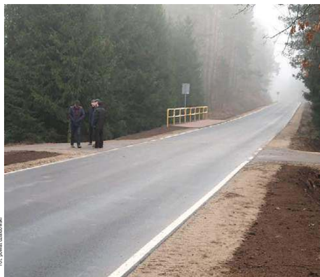
Przebudowa drogi powiatowej odc. Gralewo – Turza Wielka
