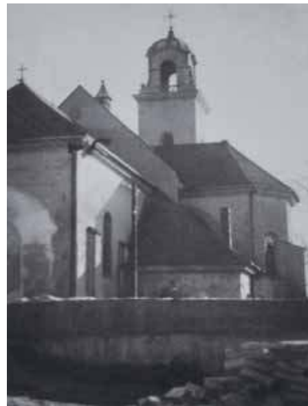
Kościół św. Wojciecha w Jaworznie. Stan sprzed II wojny światowej. W obrębie budynku widoczne fragmenty (poprzeczne) świątyni szesnastowiecznej. MMJ
