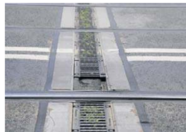
Droga świeżo po remoncie
