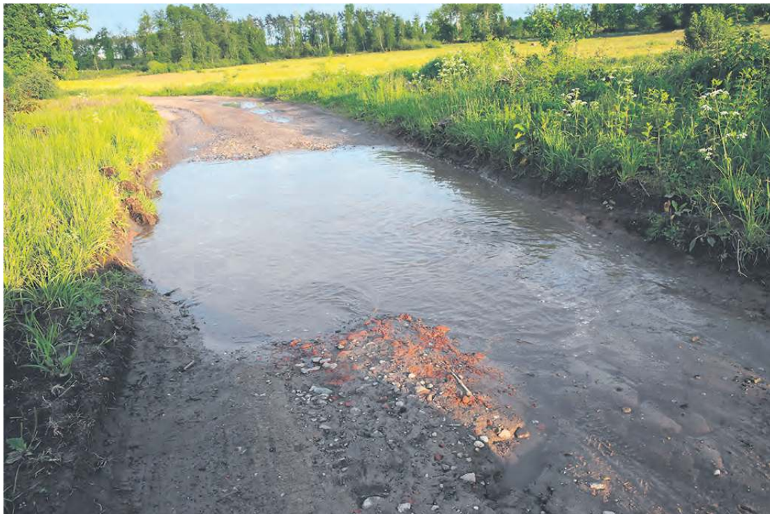
Droga na Ciechocin. Nie wiadomo, co kryje kałuża: czy trafi się na wystający kamień, czy na inną niespodziankę.
