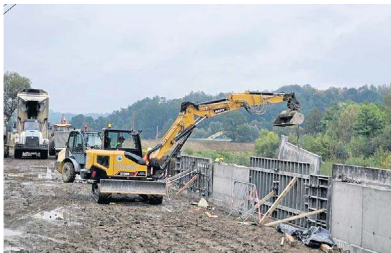
Trwa budowa wałów przeciwpowodziowych na rzece Stradomka
