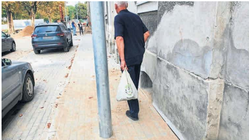
Lampa pośrodku chodnika. Mieszkańcy twierdzą, że utrudnia ona przejście, a ludzie z dziećmi w wózkach lub osoby niepełnosprawne będą musiały szukać innej drogi
