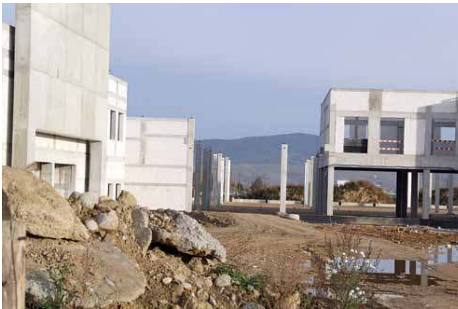
Na budowie Color Parku panuje grobowa cisza.
