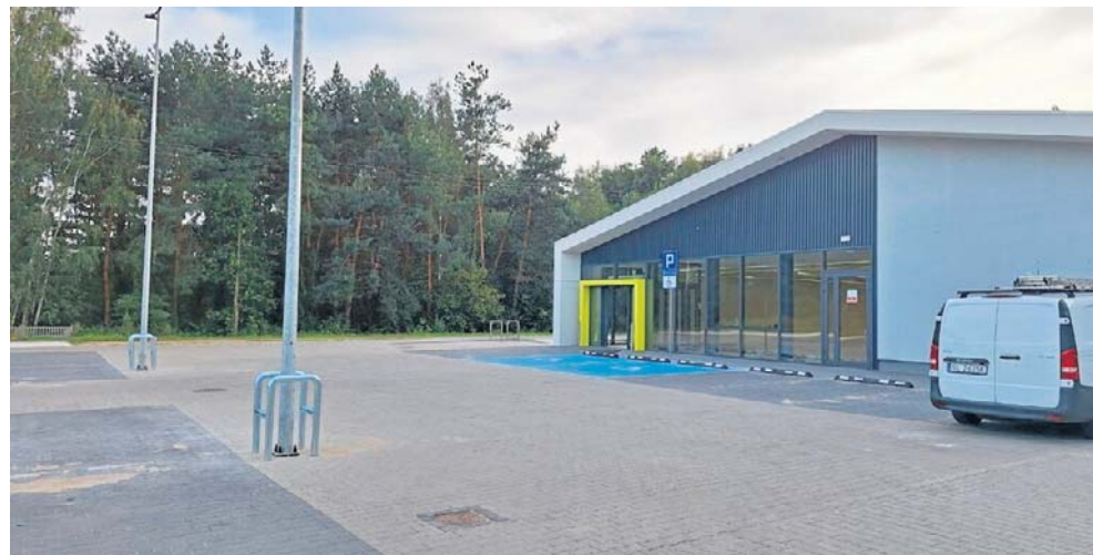
Supermarket działał tu niecałe 9 miesięcy. Zasadniczą przyczyną zamknięcia jest planowany na długi okres remont ulicy Kolumny
