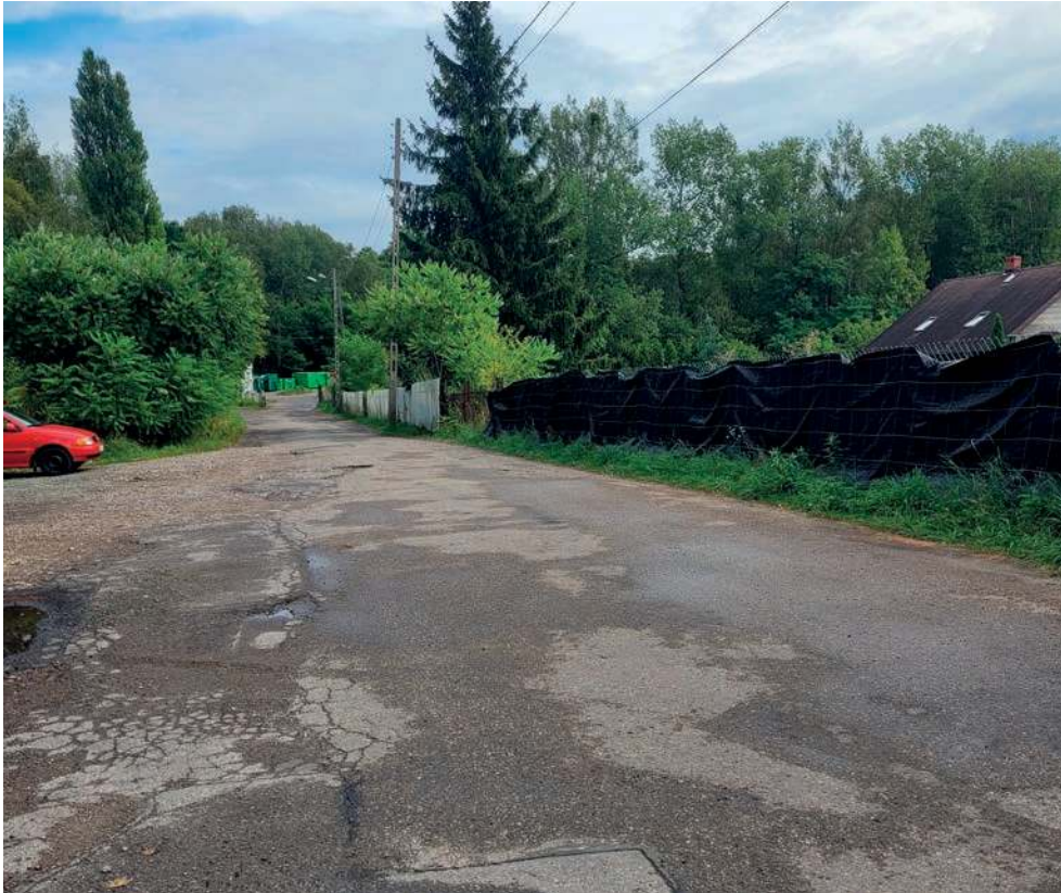
Droga do trzebińskiego PSZOK-u ma nieregulowany stan prawny. I droga, i PSZOK czekają na modernizację.
