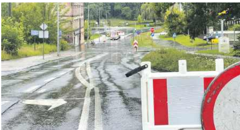
Dwa dni ulewy spowodowały zalanie kilku ulic w mieście
