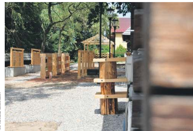
Na tzw. rynku małomiasteczkowym trwają roboty
