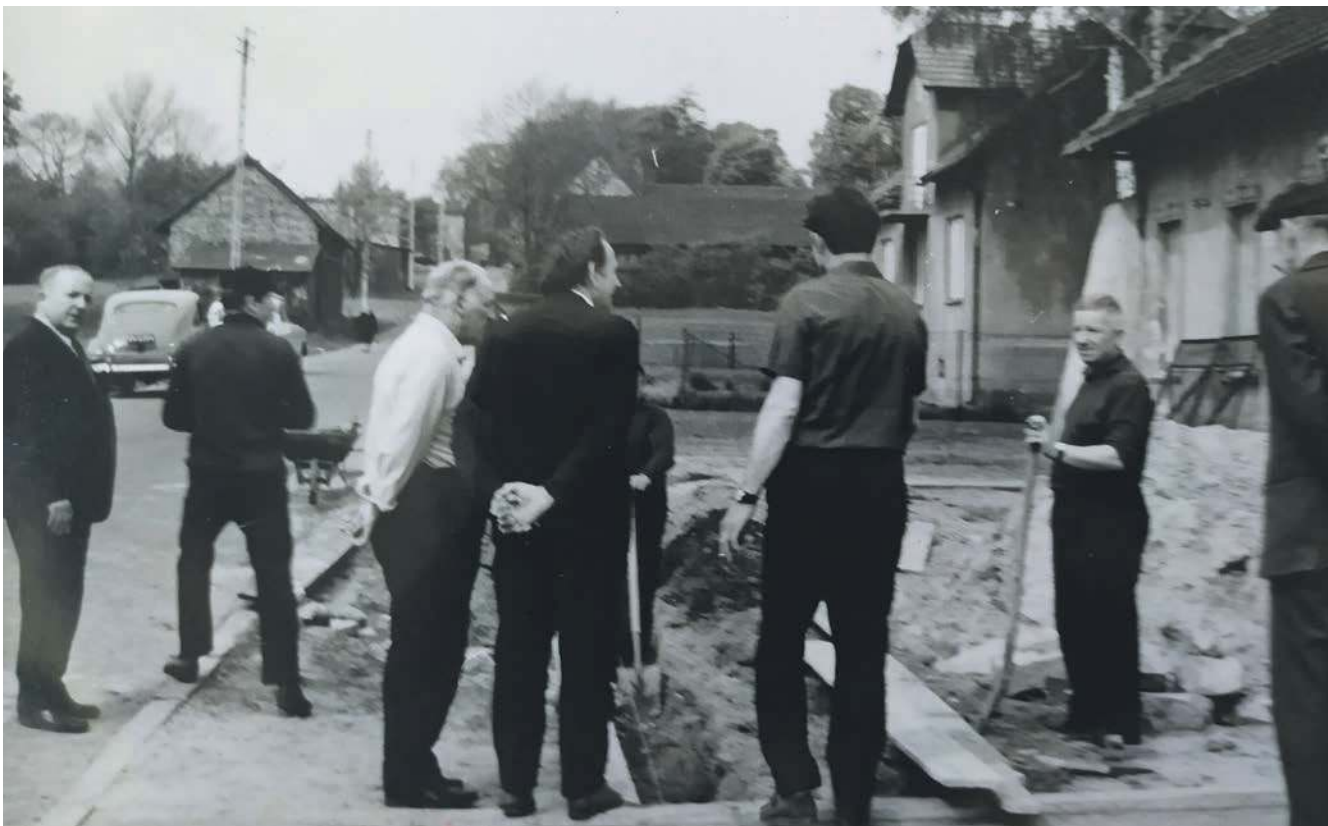
Wizytacja terenu budowy nowej szkoły w Kościelcu. Po lewej ulica Dworska, w głębi zabudowania dworskie i park, po prawej stronie widoczny fragment budynku starej szkoły. (Archiwum SP nr 6 w Chrzanowie)
