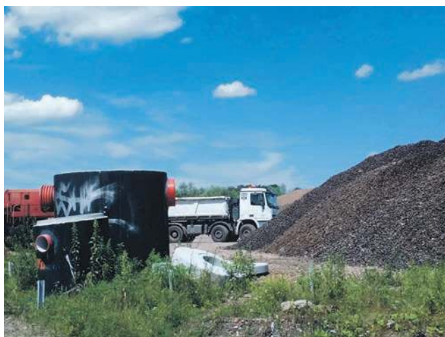
Składowanie i kruszenie kamienia ma związek z pracami prowadzonymi przez PKP przy modernizowanej linii kolejowej E-30
