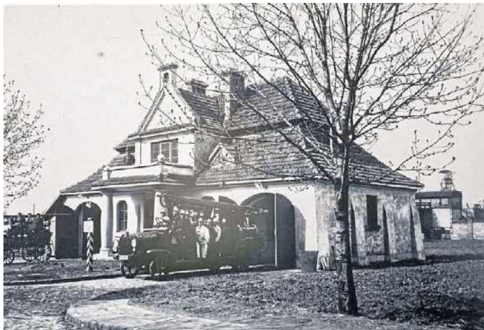
Tak budynek kopalnianej straży pożarnej wyglądał pierwotnie
