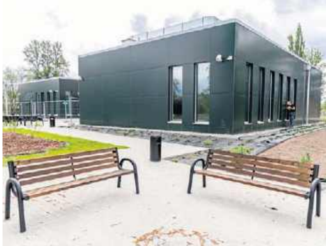
Parterowy budynek wygląda nowocześnie, a dzięki ciemnozielonej elewacji wpisuje się w krajobraz
