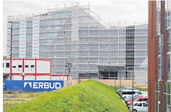
Budowa pierwszej części ECFC ma zakończyć się w 2026 r.
