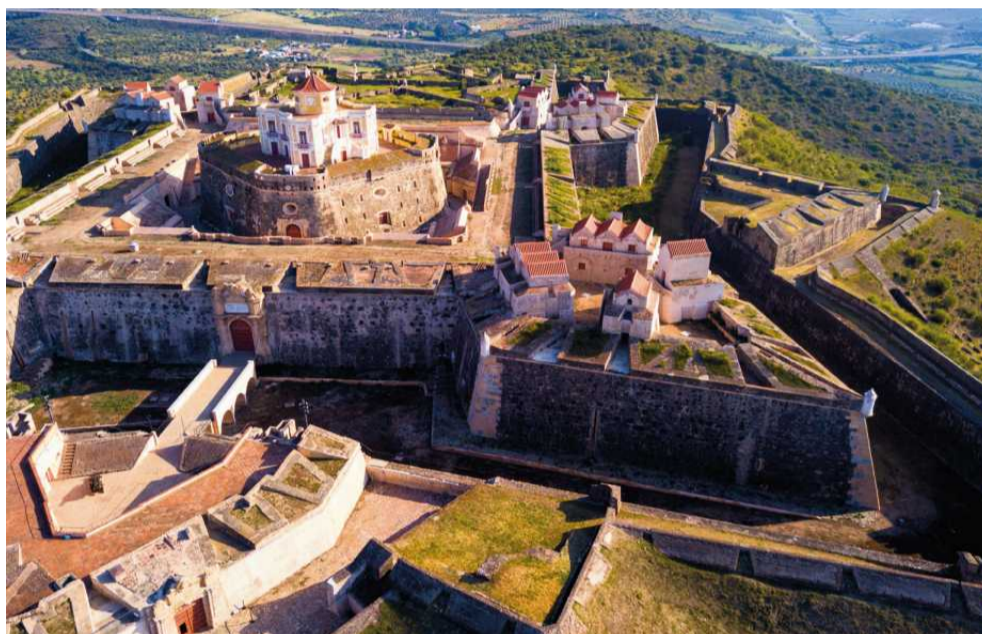
• ELVAS. Miasto-twierdza przy granicy z Hiszpanią. Od XVII do XIX w. zostało otoczone rozległym systemem fortyfikacji: murów, fortów i suchych fos o obwodzie ok. 10 km
