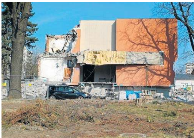
Rozbiórka Pałacu Ślubów przy ul. Zgierskiej w Łodzi już trwa
