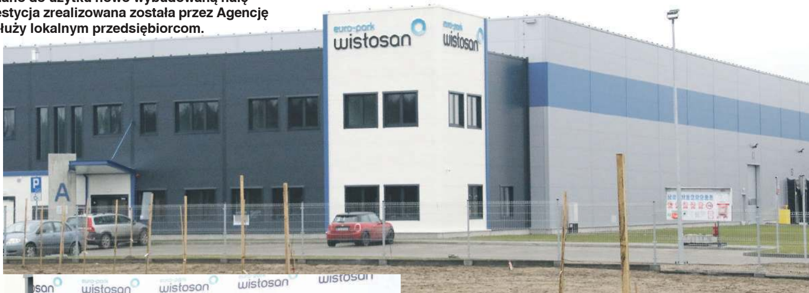
Nowa hala produkcyjno-magazynowa zlokalizowana jest przy ulicy Kasprzyskiego
