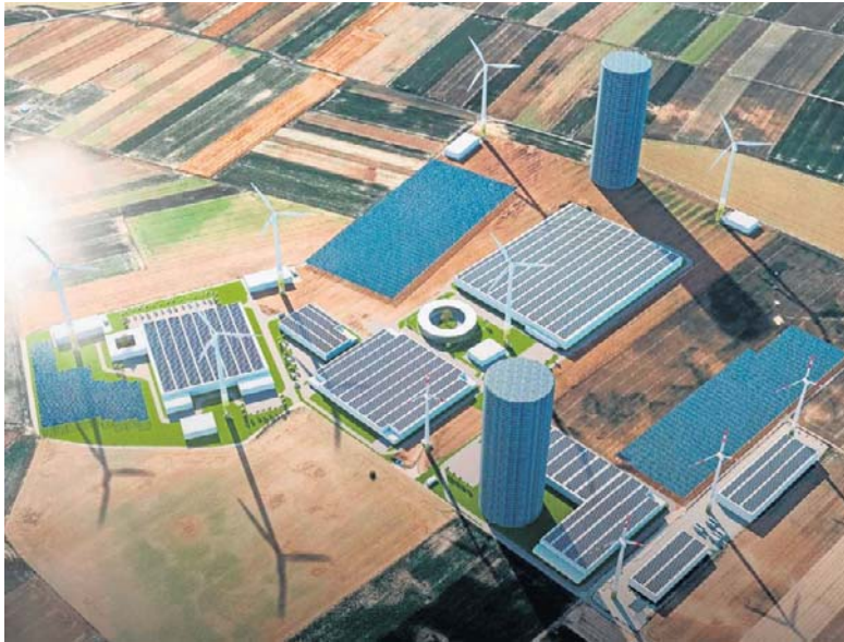
FOT. ELQ S.A. / PROMET-PLAST
