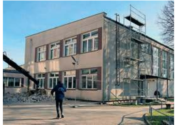
Termomodernizacja SP nr 5
