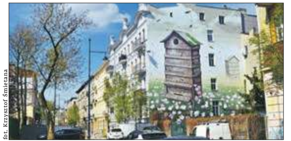
Kamienice przy ul. 1 Maja w Łodzi najprawdopodobniej zostaną rozebrane z powodu budowy tunelu kolejowego
