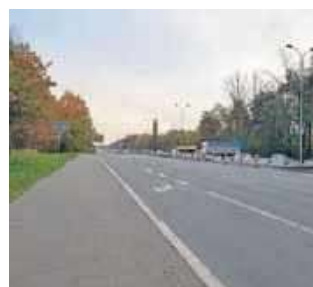
FOT. UM KATOWICE
