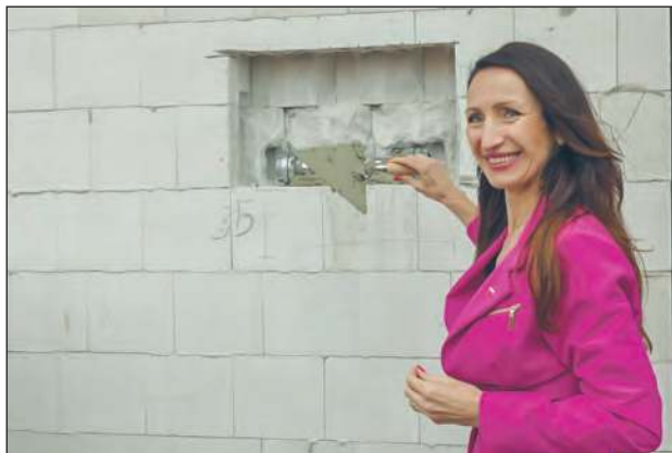
Akt erekcyjny został wmurowany w ścianę budowanej Komendy Powiatowej PSP w Garwolinie
