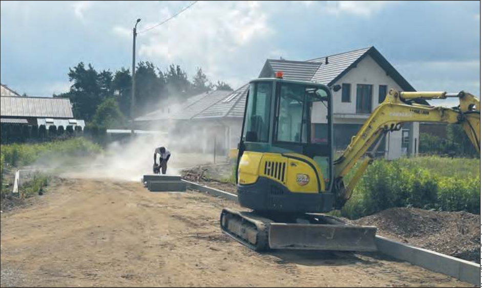
Trwają prace na ulicy Leśnej w Sobolewie
