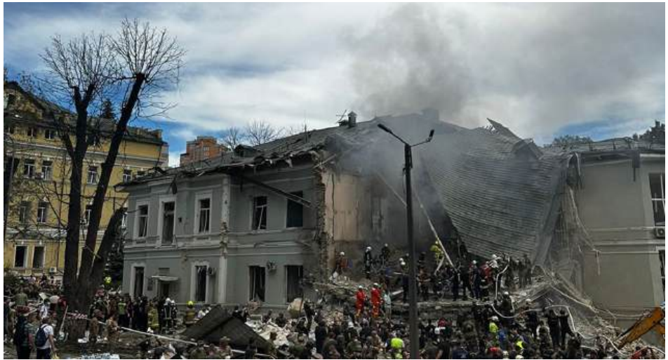
Пошкоджений історичний корпус Охматдиту. Фото: СБУ
