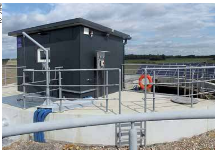
Gmina Zawidz - Przebudowa i rozbudowa gminnej oczyszczalni ścieków, remont pompowni ścieków stanowiących wyposażenie gminnej sieci kanalizacyjnej w Zawidzu Kościelnym i budowa sieci wodociągowej w Zawidzu Małym
