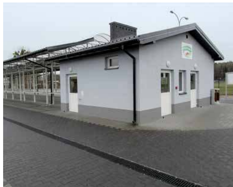
Gmina Ojrzeń - Wspieranie lokalnego rozwoju Gminy Ojrzeń poprzez rozbudowę dróg: Kraszewo - Skarżynek - Łęski Wielkie; w miejscowości Bronisławie i przebudowę ul. Przedszkolnej w miejscowości Ojrzeń
