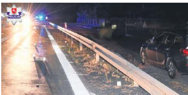
Do wypadku w Wólce Orłowskiej doszło nocą. Miejsce, w którym pieszy wszedł na jezdnię, omijając barierki, jest nieoświetlone. Fot. KPP Krasnystaw
