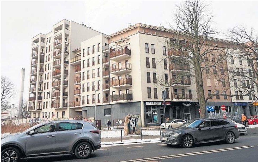
Ulica Żeligowskiego zostanie zamknięta na odcinku od Struga do 6 Sierpnia. Jeden z bloków znalazł się bardzo blisko trasy tunelu
