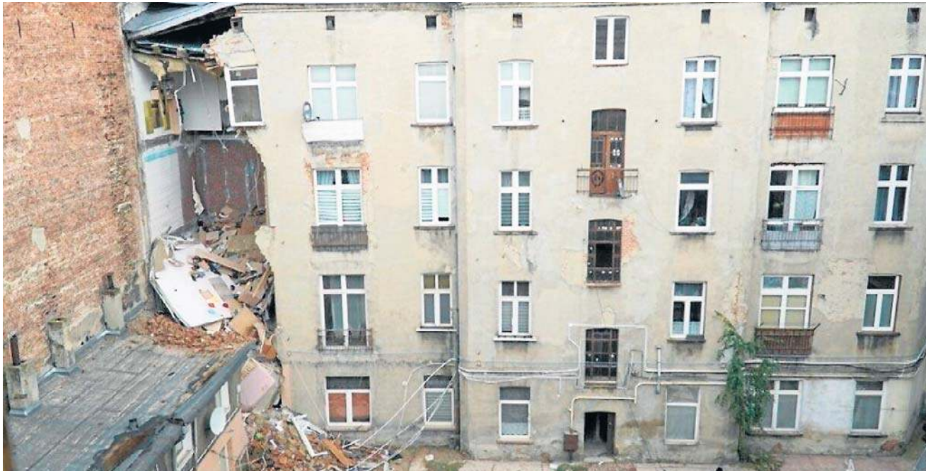
Najpierw poleciała podłoga, potem waliły się kolejne piętra w jednym z pionów kamienicy przy al. 1 Maja 23, pod którą tunel drążyła tarcza Katarzyna
