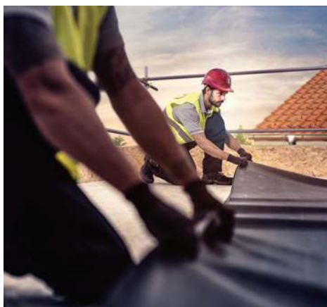
🔧 Układanie membrany EPDM – jednym arkuszem tego materiału można pokryć cały dach. GALECO
