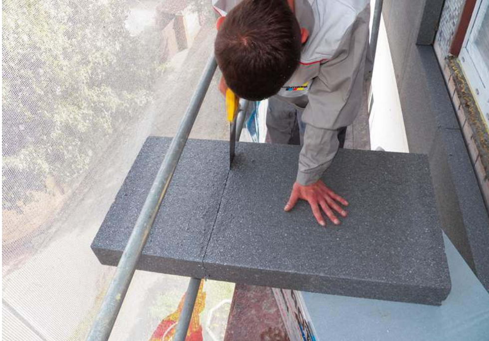
Do cięcia styropianu zwykle używa się ręcznej piły. AUSTROTHERM
