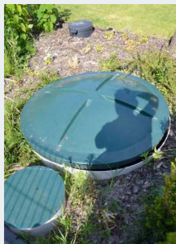
📍 Cylindryczny, sześciokomorowy zbiornik oczyszczalni biologicznej ułożono w odległości kilkanaście metrów od domu.
