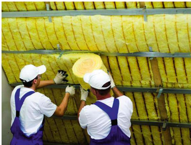
🔗 Wełna mineralna od lat króluje jako materiał do ocieplenia skosów dachu. Jest lekka, elastyczna i ma bardzo dobre parametry izolacyjne. URSA
