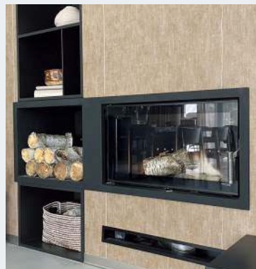
🔥 Płytki wkład, obudowę i regał umieszczono we wnęce, zlicowano z czołem ściany z ognioodporną tapetą.
