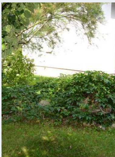
☛ Pod roślinnością znajduje się żelbetonowy dwukomorowy osadnik gnilny (w II komorze przepompownia).
