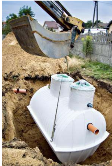
☛ Montaż przydomowej oczyszczalni ścieków. EKO-BIO/OCZYSZCZALNIA.NET
