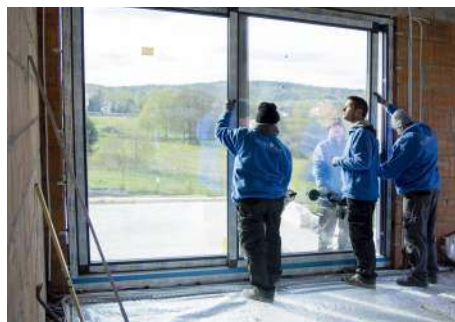
Do montażu ciężkich drzwi podnoszono-przesuwnych potrzebna jest fachowa wiedza i odpowiedni sprzęt. BUDVAR
