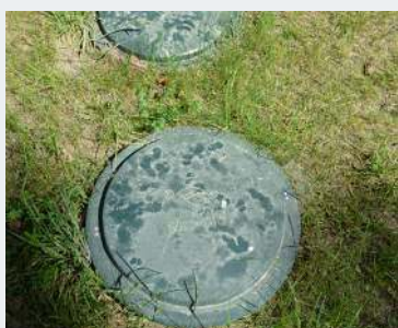
Osadnik gnilny i studzienkę rozdzielającą osadzono na zboczu wydmy.
