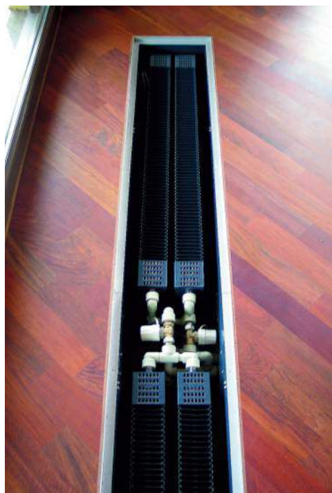
☞ Ożebrowanie zwiększa powierzchnię wymiany ciepła pomiędzy grzejnikiem i powietrzem. REGULUS-SYSTEM
