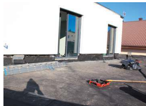
🔧 Remont nowego dachu – trzeba było wyciąć ocieplenie i wyciągnąć izolację przeciwwodną na mur. Pokrycie zmieniono z papy na membranę EPDM. J. WERNER
