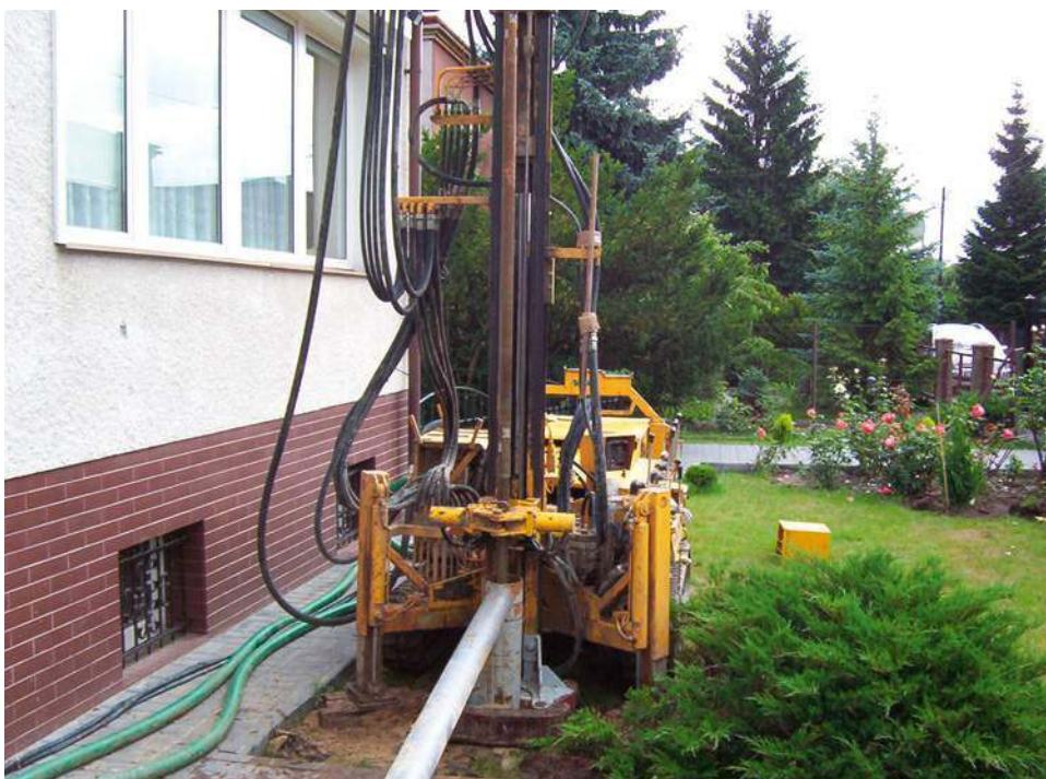
📍 Odwiert pod wymiennik pionowy. NIBE-BIAWAR
