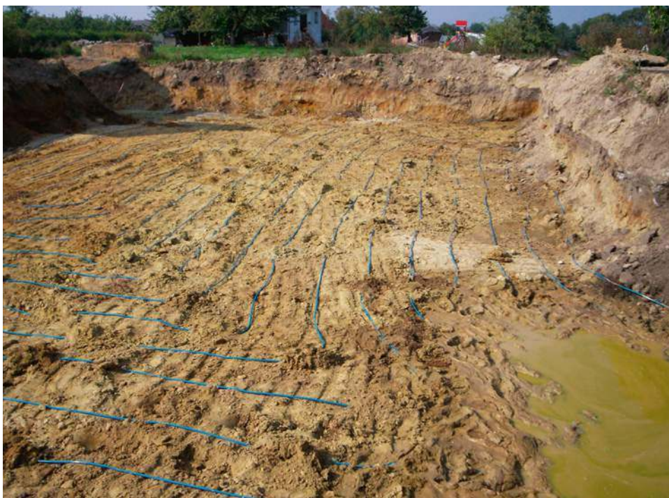
📍 Wykop pod poziomy kolektor gruntowy. CLIMA KOMFORT
