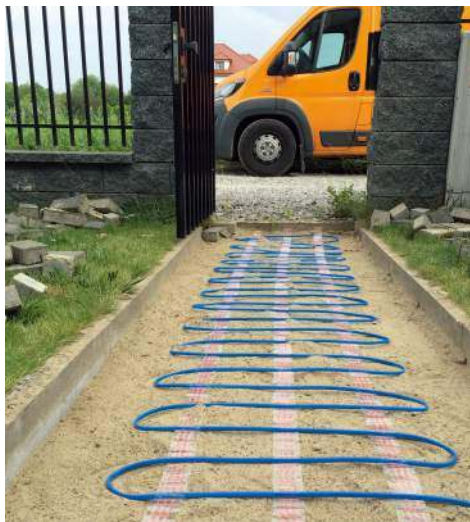
f System przeciwołodzienny montuje się na całej szerokości ścieżki. NVENT THERMAL
