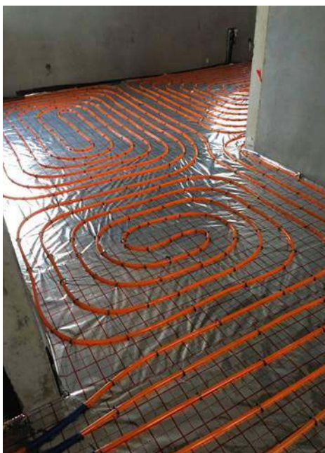
📌 Pompa ciepła najlepiej współpracuje z niskotemperaturowym ogrzewaniem płaszczyznowym, czyli podłogówką. RWC
