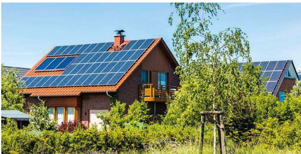
🔗 Planując liczbę paneli można przyjąć, że z 1 kW ich zainstalowanej mocy otrzymamy rocznie 1000 kWh energii. VAILLANT
