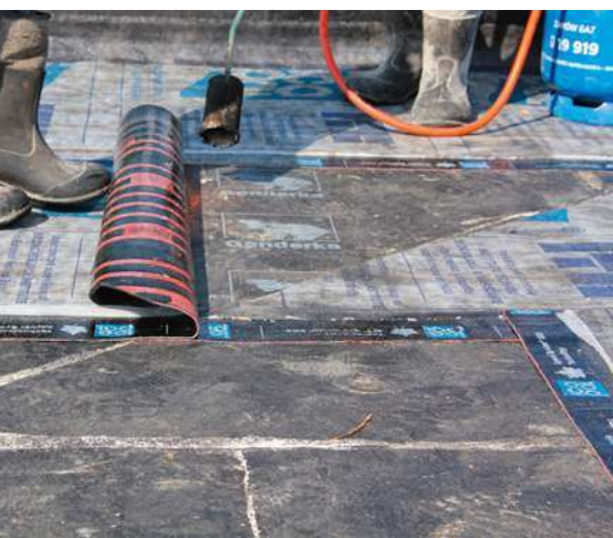
📍 Zgrzewanie papy podkładowej. J. WERNER
