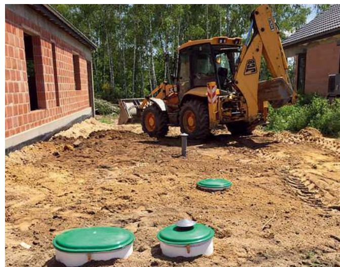
📍 Oczyszczalnię ścieków wykonuje się przed zagospodarowaniem ogrodu. EKO-BIO/OCZYSZCZALNIA.NET
