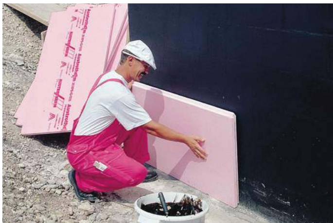
📌 Materiał użyty do izolacji ścian fundamentowych, piwnicznych oraz płyt fundamentowych powinien być nie tylko wytrzymały, ale także szczególnie odporny na zawilgocenie. AUSTROTHERM
