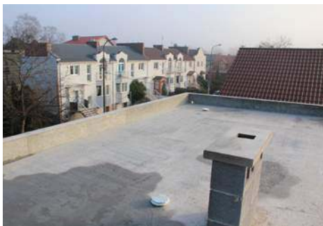
📍 Strop nad ostatnią kondygnacją, czyli żelbetowa konstrukcja dachu płaskiego. J. WERNER
