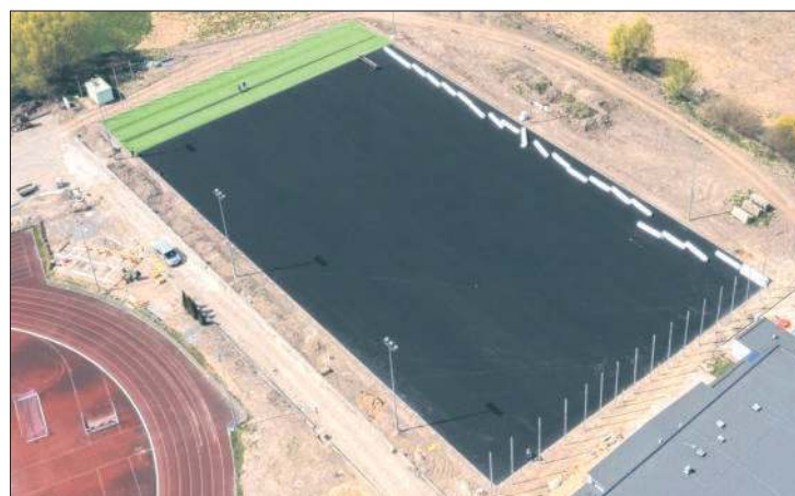
Teren HOSiR przechodzi gruntowną przebudowę.
