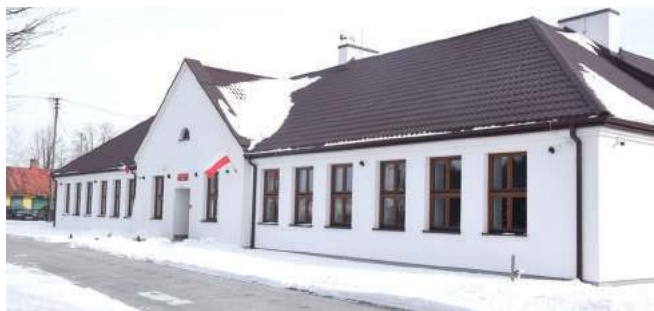
Centrum znajduje się w byłym budynku po szkole podstawowej
