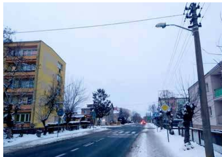
Widoczna na zdjęciu lampa z powodu odległości nie jest w stanie oświetlić skutecznie przejścia dla pieszych
