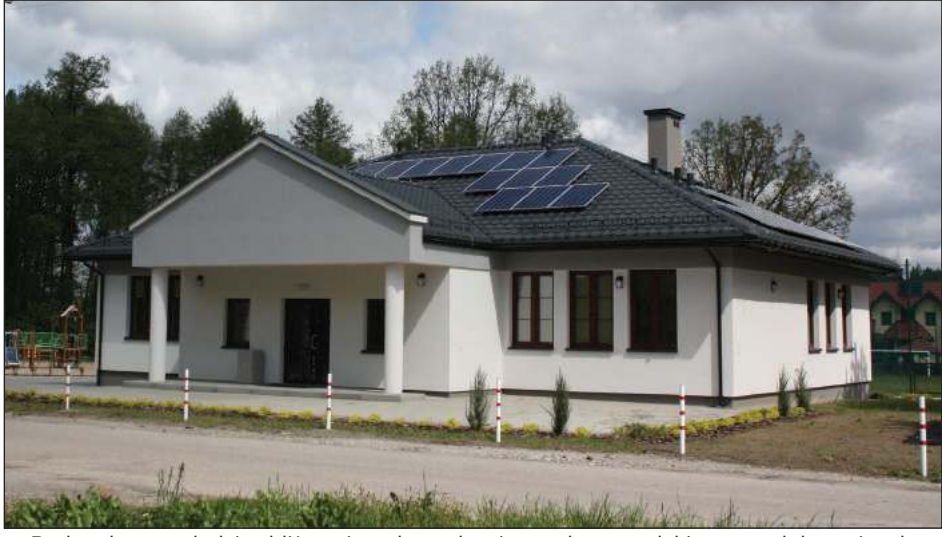
Budynek w wyglądzie zbliżony jest do tradycyjnego dworu polskiego z ozdobnymi zadaszeniami wejść do budynku. Obok znajduje się zrobiony już wcześniej plac zabaw i boisko
