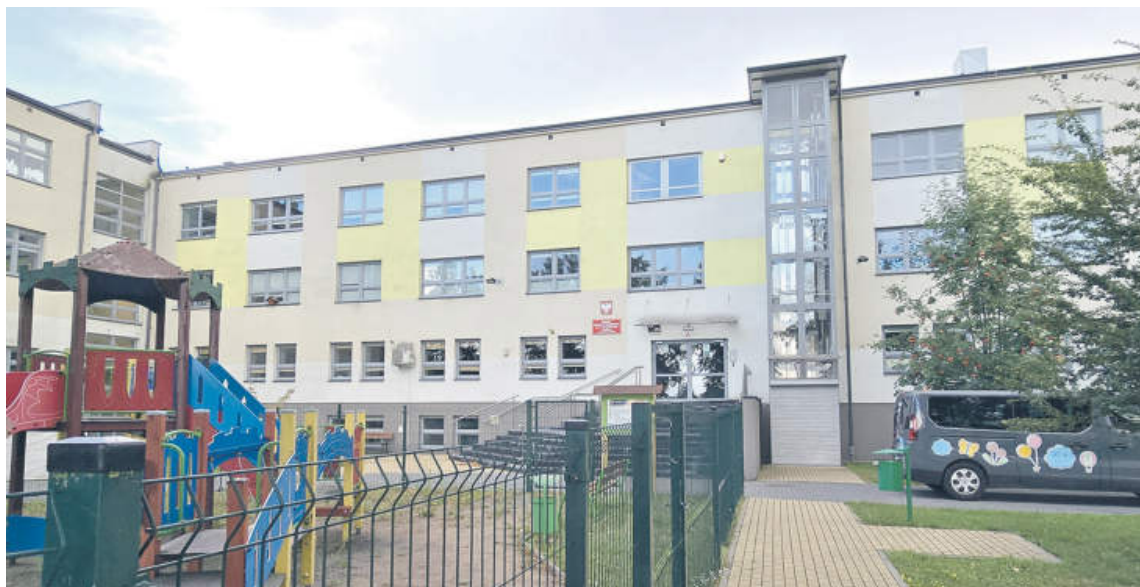
Budynek Specjalnego Ośrodka Szkolno-Wychowawczego im. M. Grzegorzewskiej w Siedlcach przy ul. Kazimierzowskiej.
