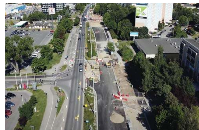
Ul. Pstrowskiego w trakcie remontu w 2023 roku
